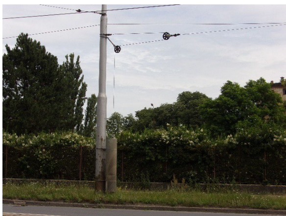
Obr. 5: Pohyblivé kotvení prostého vedení kladkostrojem v poměru 1:2
