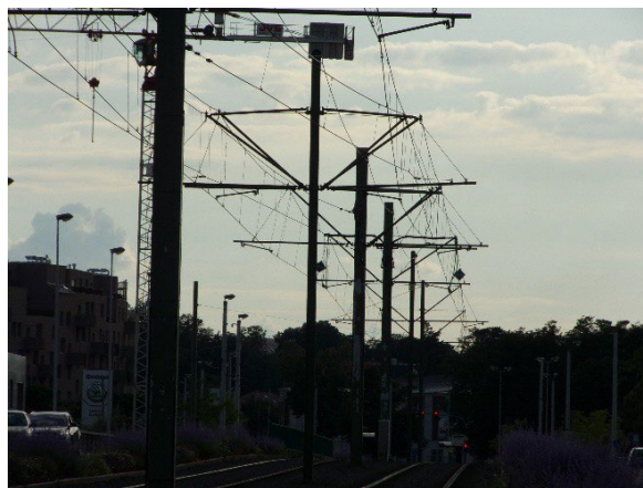
Obr. 2: Výměnný úsek řetězovkového vedení
