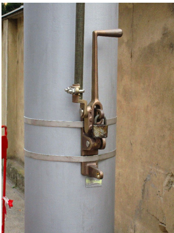
Obr. 38: Ruční pohon odpojovače
