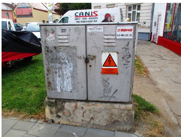
Obr. 50: Kabelová skříň – rozvaděč
