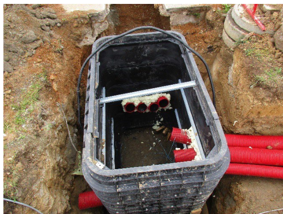
Obr. 47: Ochranná trubka v kabelové komoře
