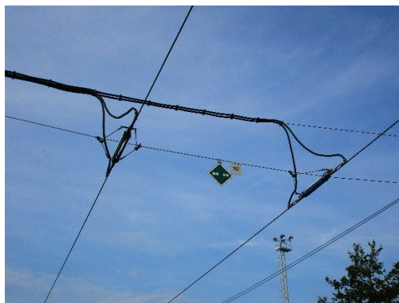
Obr. 41: Umístění návěstidla úsekového dělení
