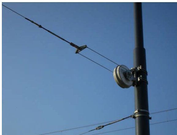
Obr. 7: Napínací zařízení Tensorex
