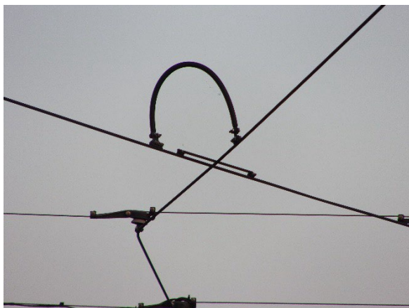
Obr. 15: Křížení pomocí přeponky do 50°
