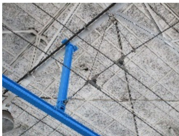
Obr. 26: Trakční vedení na nosné konstrukci budovy
