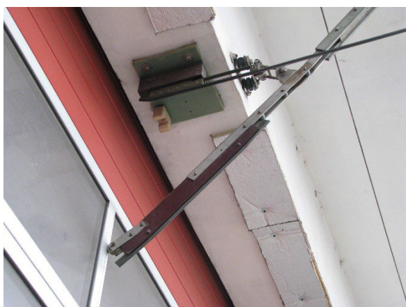
Obr. 13: Konstrukce sklopné troleje při spuštěných rolovacích vrátech
