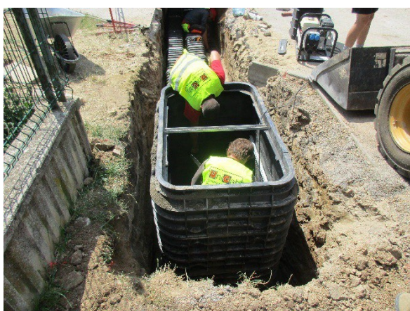
Obr. 48: Kabelová komora
