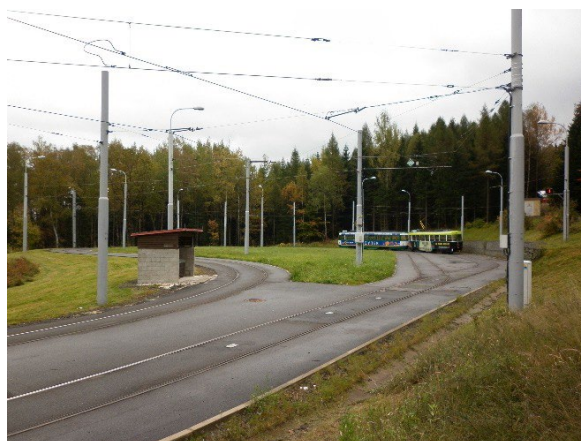
Obr. 4: Pevné kotvení řetězovkového vedení
