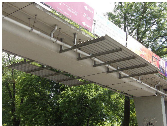
Obr. 12: Protidotykové zábrany upevněné na konstrukci mostu
