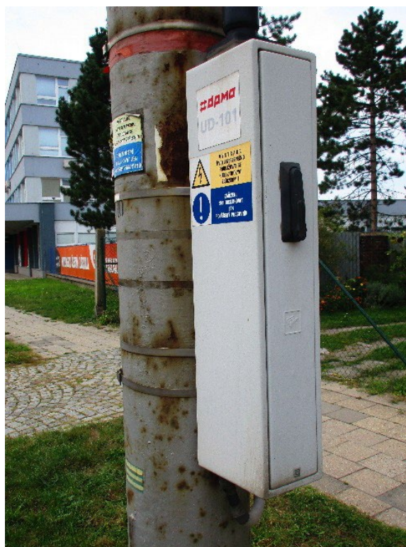
Obr. 39: Motorový pohon odpojovače
