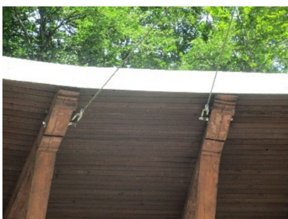
Obr. 23: Trakční vedení na dřevěné konstrukci
