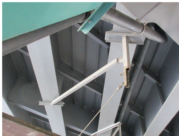
Obr. 20: Trakční vedení pod mostem
