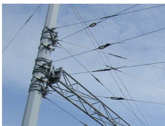
Obr. 24: Trakční vedení na nosné konstrukci
