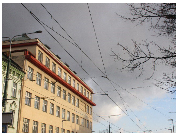
Obr. 10: Pevný bod řetězovkového vedení
