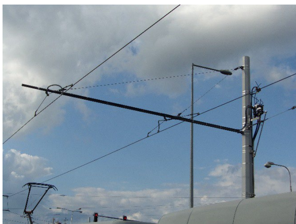
Obr. 42: Propojovací kabely na výložníku
