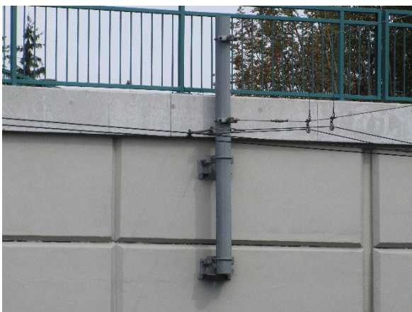
Obr. 27: Trakční vedení na zkráceném stožáru
