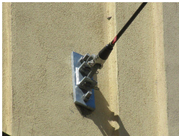
Obr. 18: Horizontální kardan s parafílem
