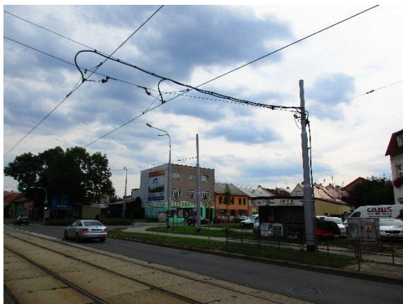
Obr. 29: Napájecí bod
